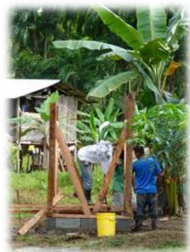
Construcción de baño – Bisira 2012
