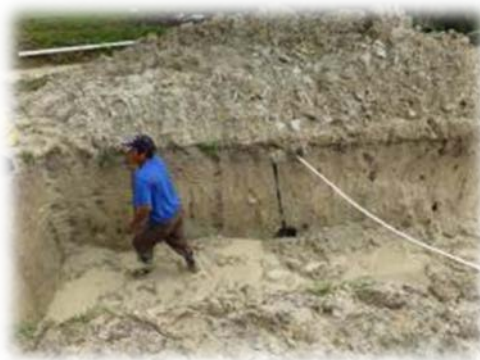
Fosa cavada para el filtro de saneamiento - Bisira 2012
