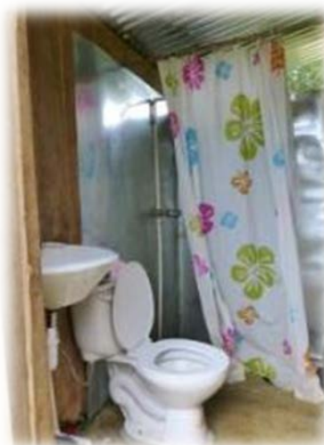
Baño instalado en Cerro Ñeque 2012
